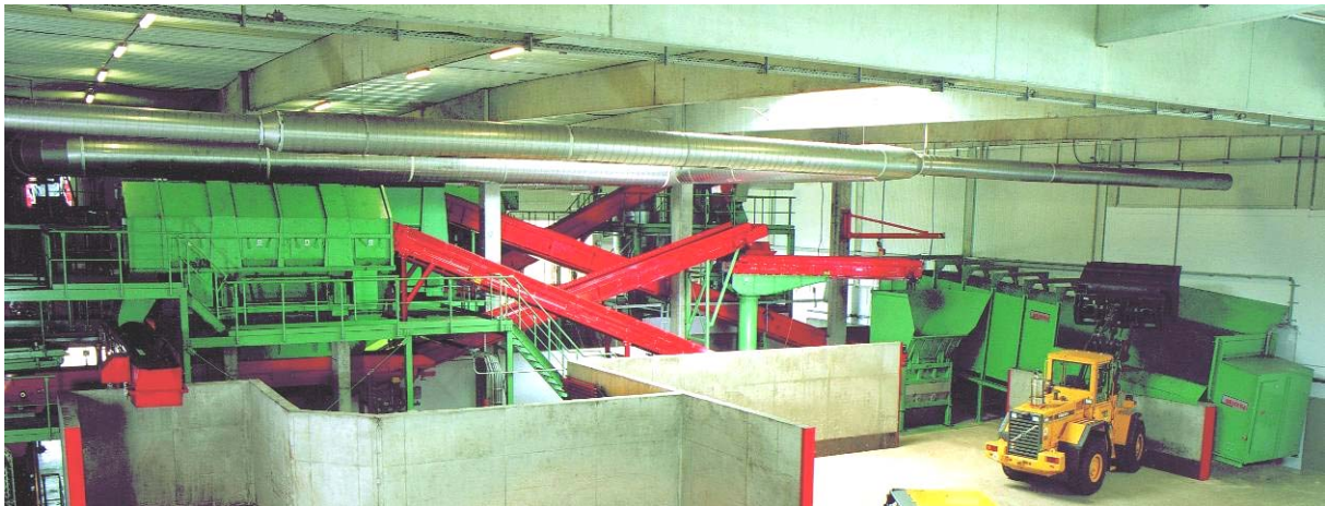
Aufgabe in den Walkingfloor-Bunker, Absiebung, Aufbereitung durch Schneckenmühle, weitere Siebung, Magnetabscheider
