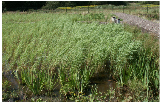
Pflanzenkläranlage zur Behandlung der Oberflächenwässer, rechts Damm und Klarwasserbecken
