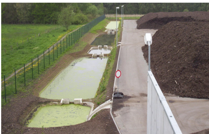
Auffanggräben für Oberflächenwasser mit in Reihe geschalteten Absetzbecken
