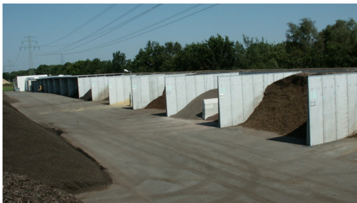
Boxengasse als Warenlager (im vorderen Bereich ohne, hinteren Bereich des Bildes mit Überdachung)
