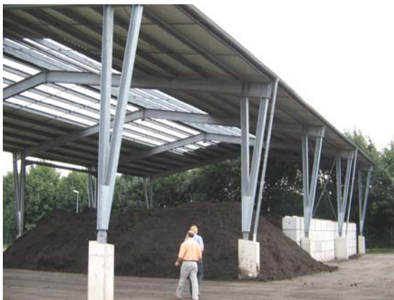
überdachte Nachrotte und Lagerhalle
