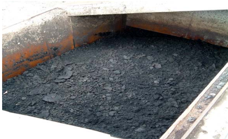
Tiefbunker mit Klärschlamm
