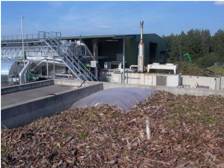
Vergärung: Fermenter, Biofilter (Probenahme)
