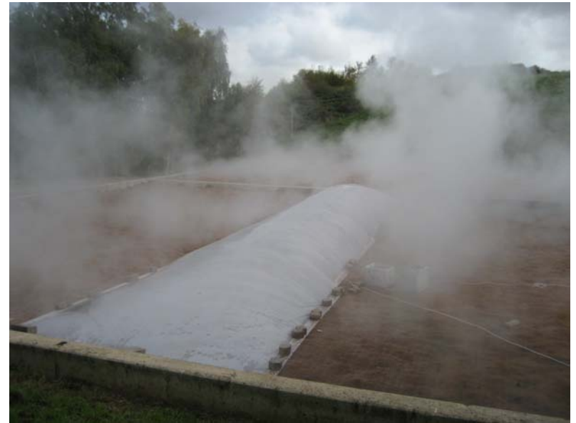
offener Biofilter mit Probenahme
