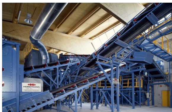
Abbildung 1: Aufbereitungstechnik bei der Inbetriebnahme im Jahr 1997.
