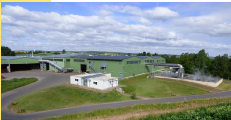
Kompostierungsanlage Kreis Euskirchen
